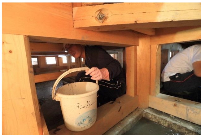
④ 床下の土砂を中央に集めている様子
