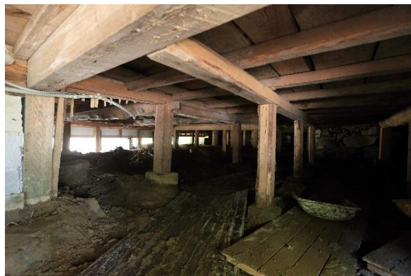
⑦ 奥に進むにつれ、搬出作業が難航
